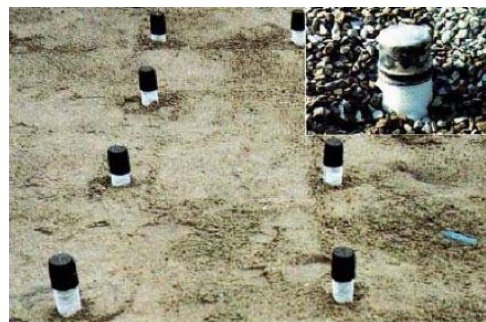
間隙水圧消散工法の例
