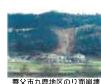
養父市九鹿地区のり面崩壊
