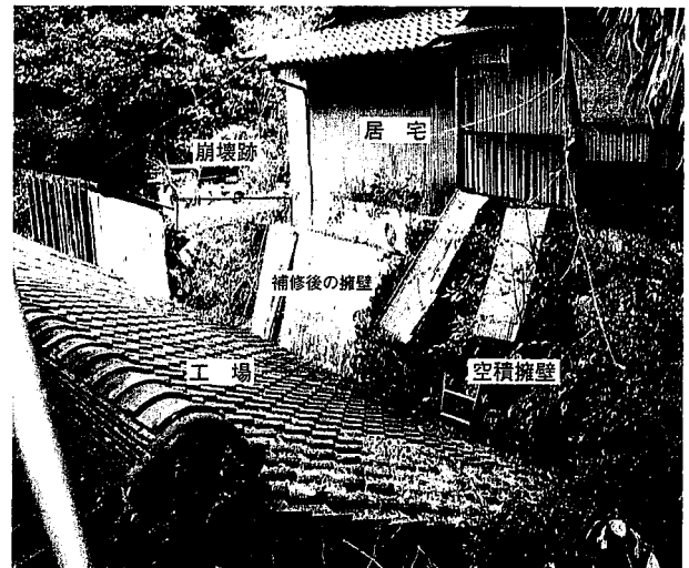
写真-2 評価対象の擁壁 (写真中央部の石積擁壁)
