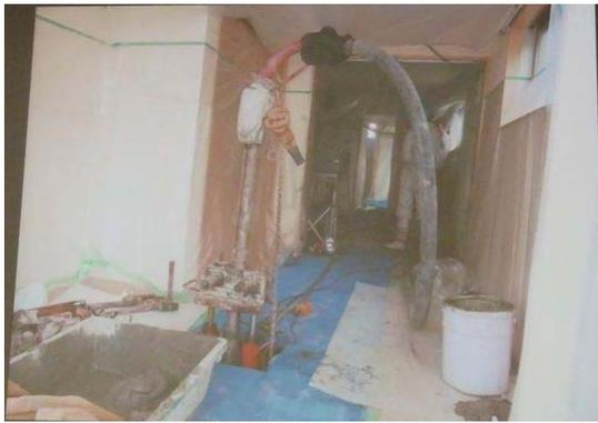
(住宅底版からの圧入締固め工法の例)
