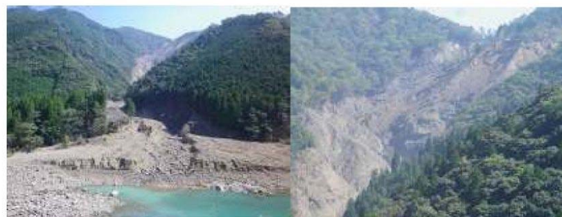
写真 6-1-6-1 野尻崩壊全景
