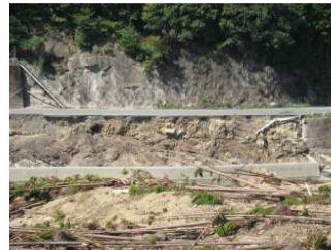
写真 6-1-3-2 崩壊地上流部の東西方向の河川右岸に見られる地層の層理面 (東側に傾斜する層理面が確認される)
