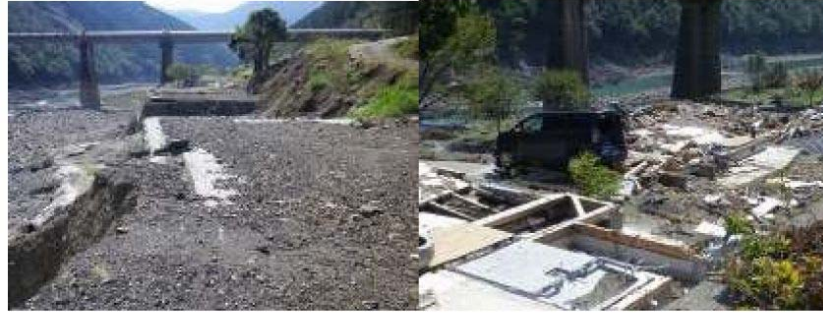
写真 6-1-6-5 野尻崩壊対岸の家屋流失の平地
