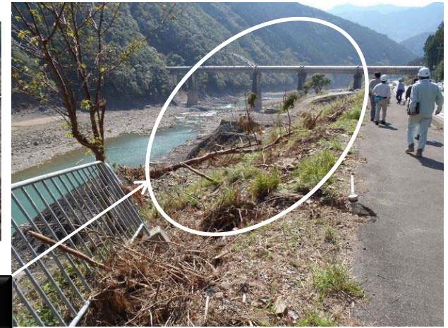
写真 6-1-6-6 野尻の流失家屋跡
