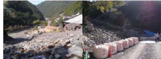
写真 6-2-1-7 土石流による家壁の被災
