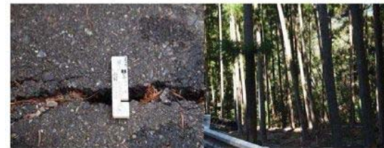
写真 6-3-2 側方境界と思われる亀裂
