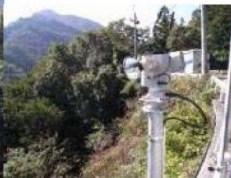
写真 6-2-2-2 国土交通省による監視カメラ
