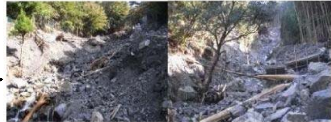
写真 6-2-1-5 崩壊土で覆われた取場
