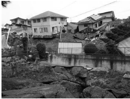
写真8 大規模な盛土崩壊
