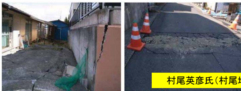
図3.9 IIブロック内の地すべりブロック側方亀裂
