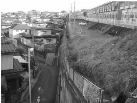
写真5 末端部の大規模な擁壁と盛土
