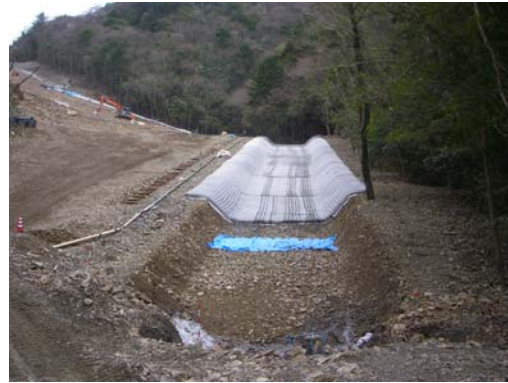
長殿 仮排水路工 (布製型枠)
