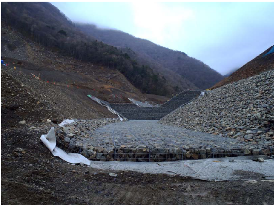
仮排水路工（下流から） 床固め工の水平部分の最下流部でこれより斜路となる。 右岸側はかごマット工未施工。
