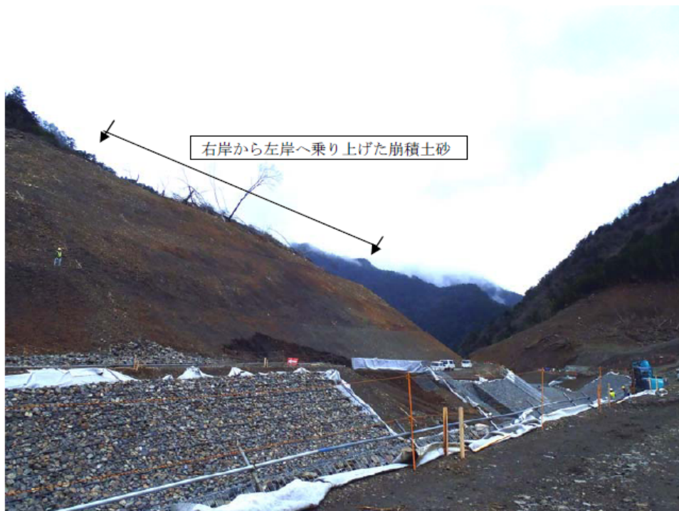
導水路床固め工の施工状況。左岸側を、上流より下流を望む。 かごマット工より上部は右岸から左岸へと乗上げた崩積土で、1:1.5の勾配で掘削・整形されている。
