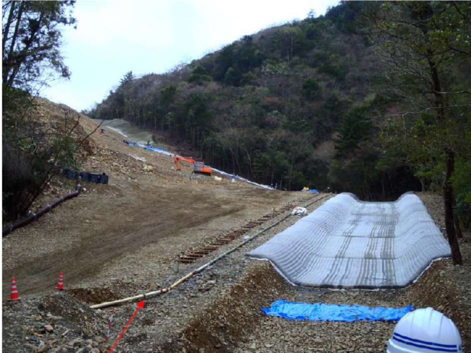
緊急対応仮排水路傾斜部（布製型枠による） 水路底幅：6 m
