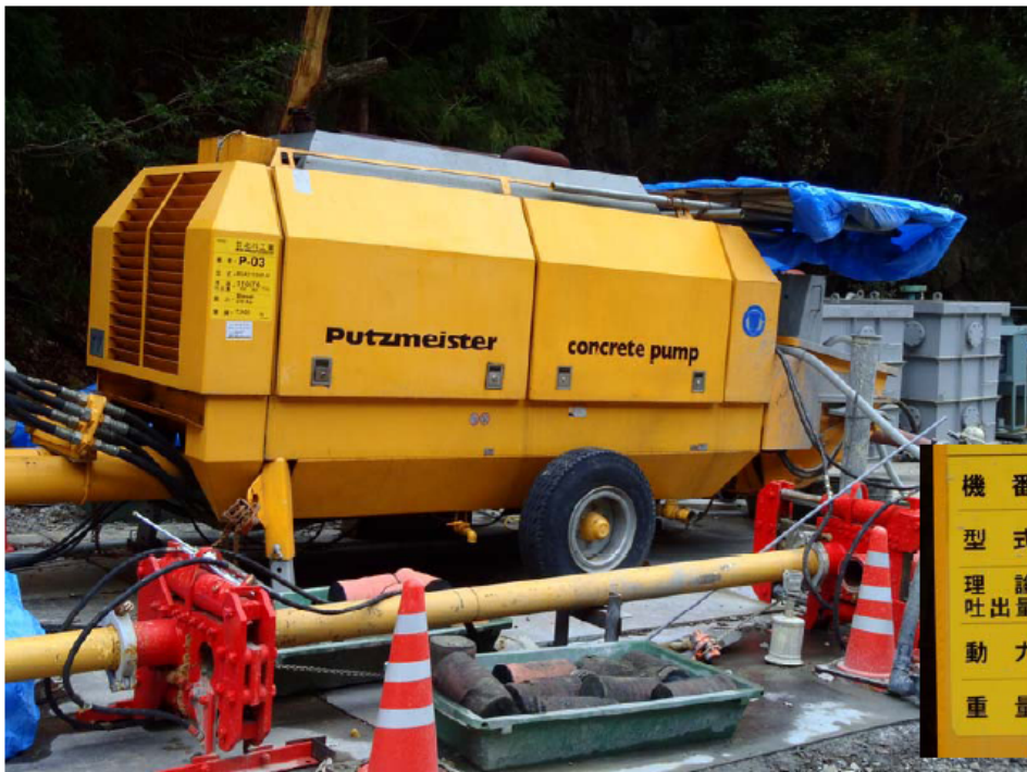
コンクリート圧送ポンプ 布製型枠に充填するコンクリートは、崩壊を生じた谷の出口に近い位置に設置されている。谷沿いにパイプが敷設されており、コンクリートは、土砂ダムの天端まで圧送されている。
