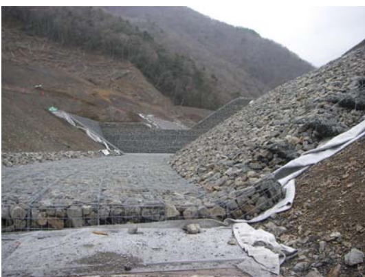
赤谷 仮排水路工（かごマット）
