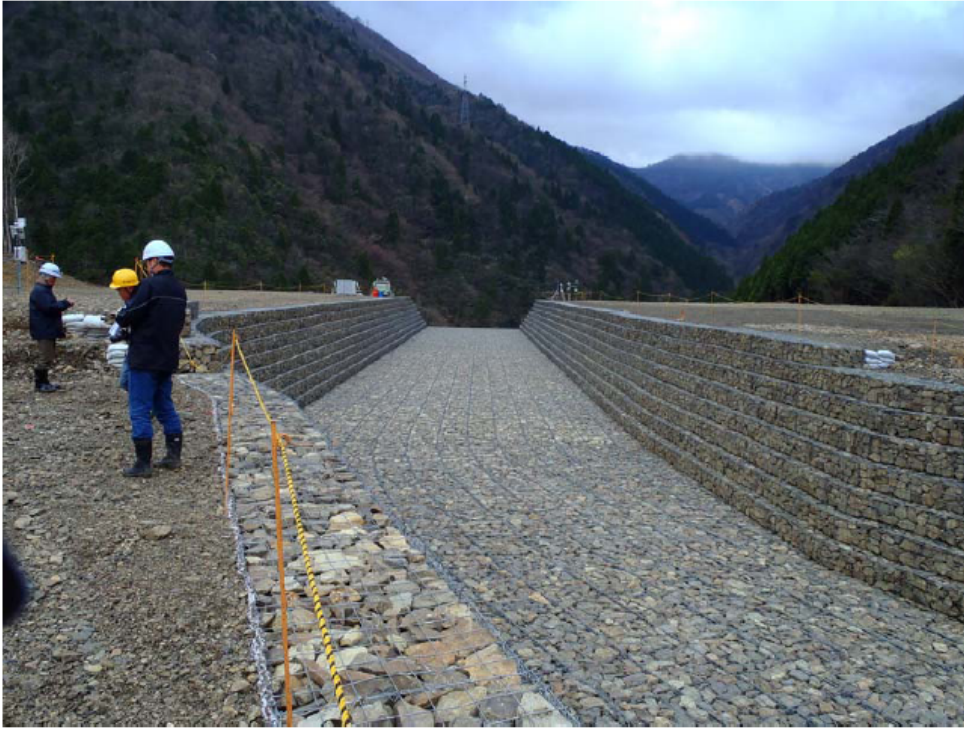
土砂ダム天端は整地・整形され、天端（頂部）に上幅：16m、底幅：12m 延長 114m の水路が、かごマットで作られている。
