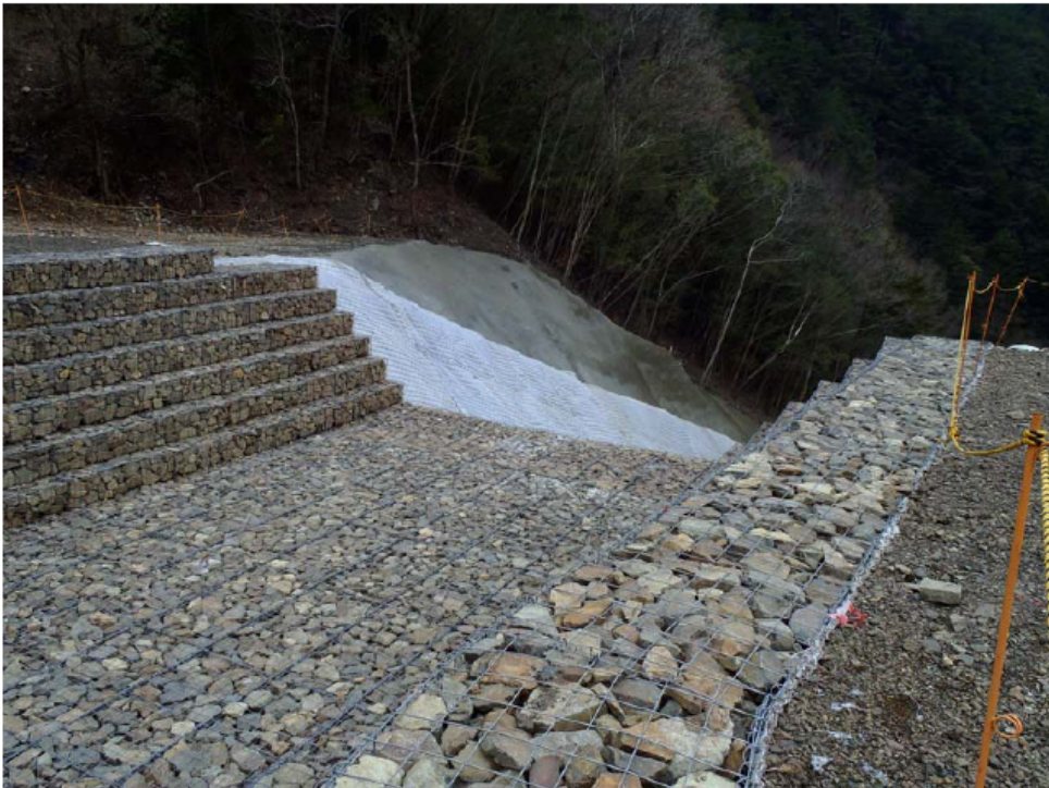
天端水路と斜面部水路のすり付け部の状況 かごマットに使われている礫（砂質岩が大部分）は現地発生材。
