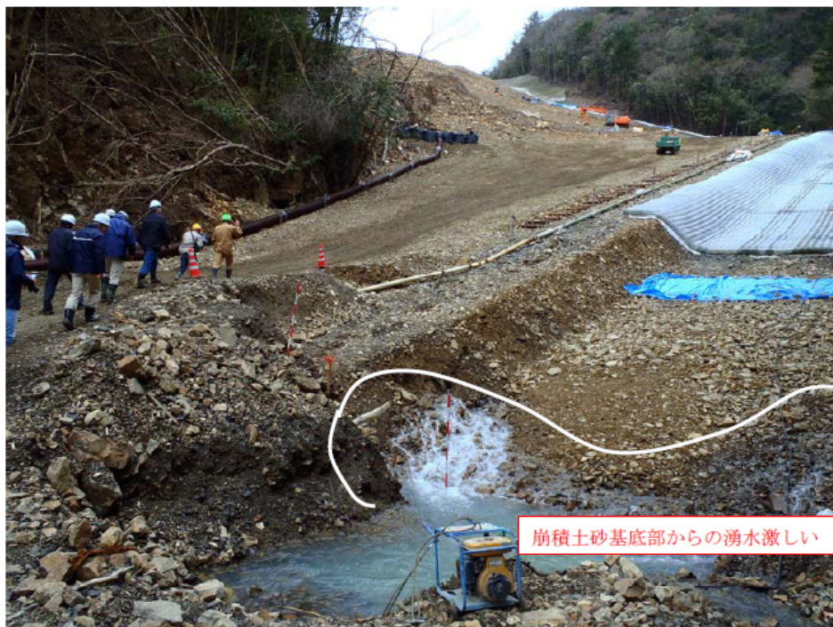
土砂ダム下流端では、崩積土の基底部より漏水が著しい。 漏水は、白濁しているが、肉眼では土粒子の洗い出しは認められない。 崩積土は、準安定状態にあるのか？ とにかく現段階は、越流に対しての緊急対応を優先しているようだ。
