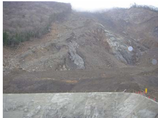
赤谷土砂崩壊現場
