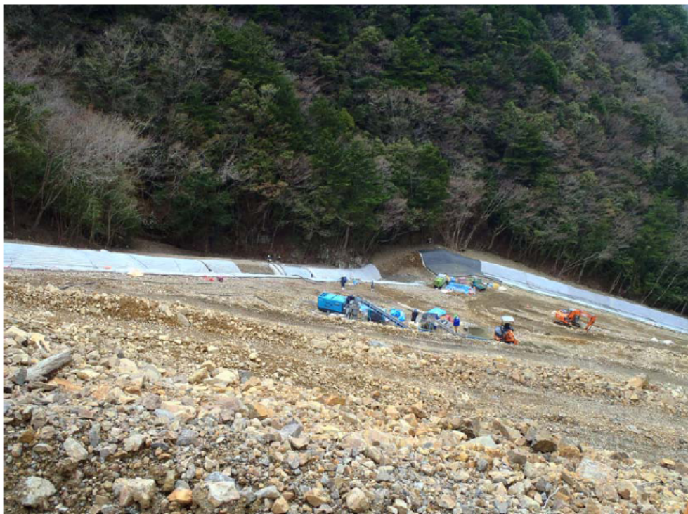
崩積土の下流面は、ラフであるがロックフルダムの下流面のように整形されている。表面は、10～30cm 大の砂質岩の角礫が卓越している様子が見られる。
