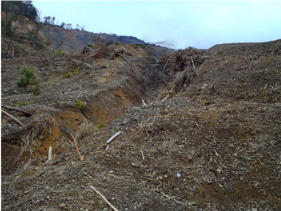
土砂ダム右岸よりには、おそらく緊急の水位低下を計るために設けられたと推定される溝が掘削されている。幅：4m, 深さ3m程度
