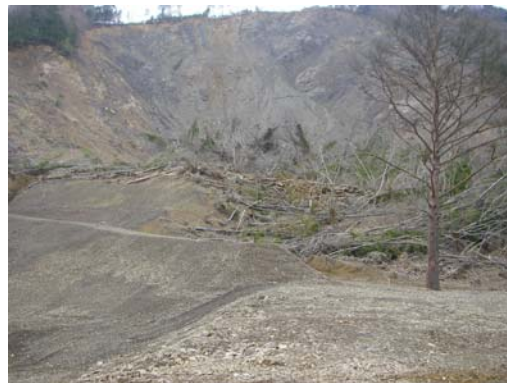
長殿 崩壊現場
