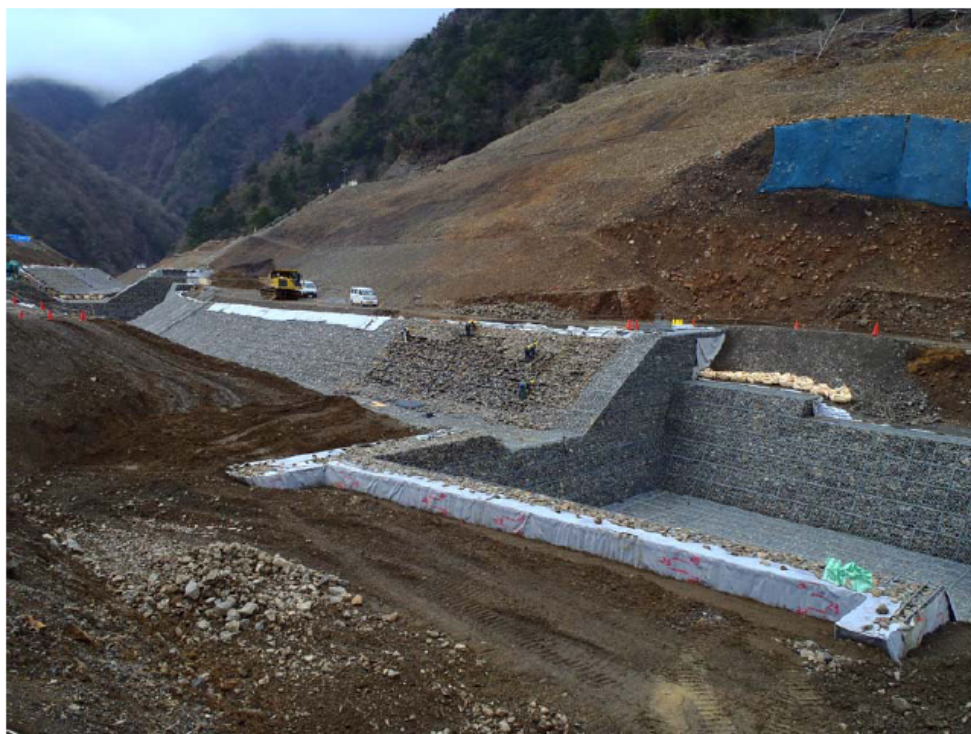
仮排水路 かごマットによる床固め工、落差工の施工状況 かごマット充填材料は、現地発生土による。
