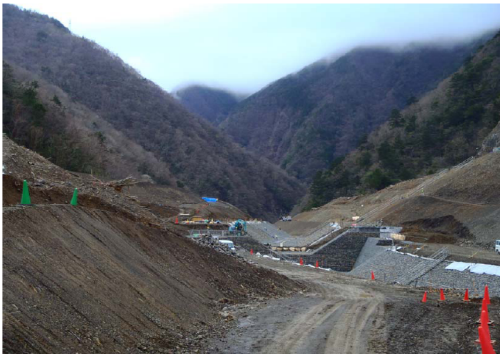
土砂ダムの頂部に設けられているかごマット工による仮排水路の全景 床固め工が構築されている。 以下の写真から推定されるように、崩積土砂は10数m断ち割り掘削されているようである。
