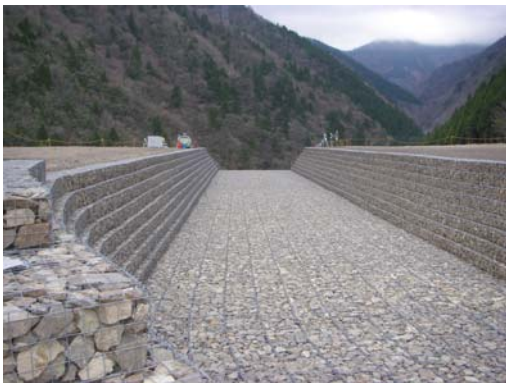
長殿 仮排水路工
