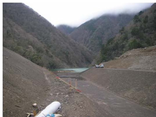
赤谷 仮排水路工（最上流）
