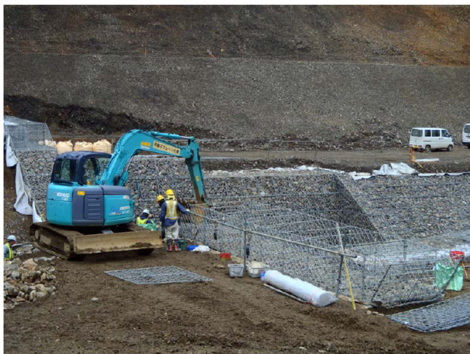
仮排水路 かごマット組立て状況
