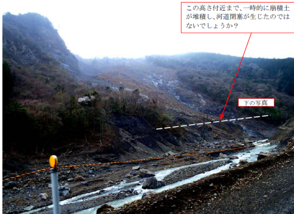
赤谷崩壊地へ行く途中、川原樋川本川右岸に見られた崩壊地 ここもかなりの大きさですが、崩積土の末端の様子を見ると、次の写真に示すように、河道を一時的に閉塞した崩積土は掃流されているようです。本川の流量が多いため河道閉塞という状況に至らなかったのではないのでしょうか？
