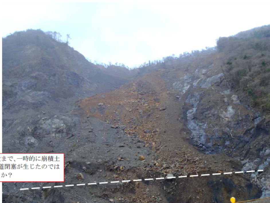
赤谷崩壊地へ行く途中、川原樋川本川右岸に見られた崩壊地 崩積土の末端は浸食され、河道閉塞を免れたように見えます。
