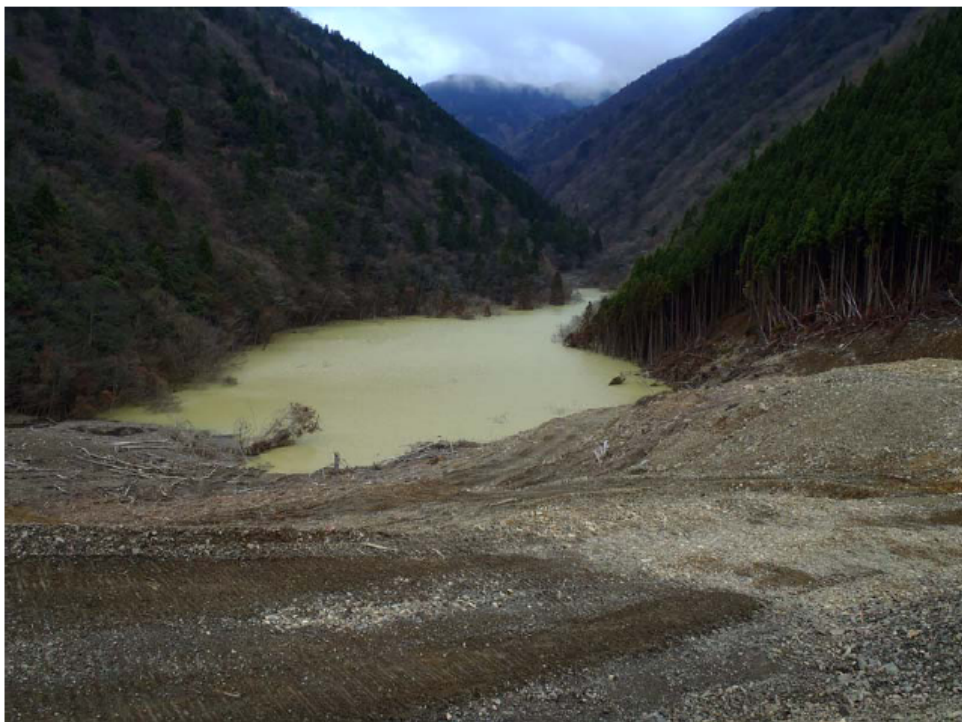
現状の淡水状況。 水面高さは、天端より約 30m 程度低い位置にある。
