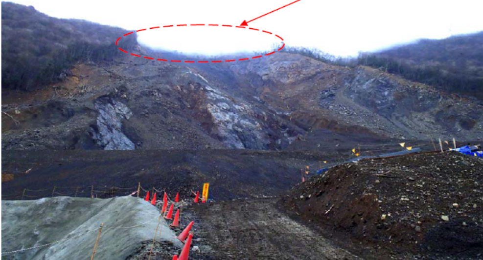
赤谷崩壊地の全景 あまり大きすぎて、全景は納まっています。天候の影響で、上部は雲に隠れて見えませんでした。 崩積土は、長殿に比べると泥質岩が卓越しているようでした。
