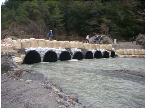
長殿 崩壊現場入り口 熊野川仮道路
