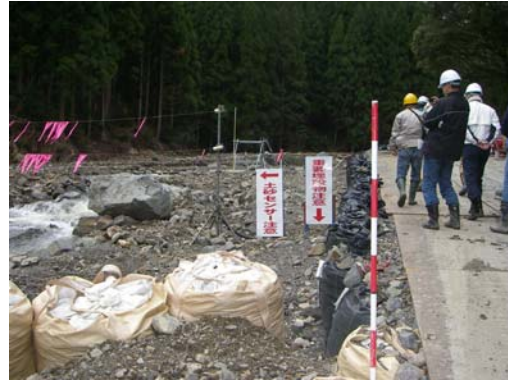
随所に設置されている地滑りセンサー
