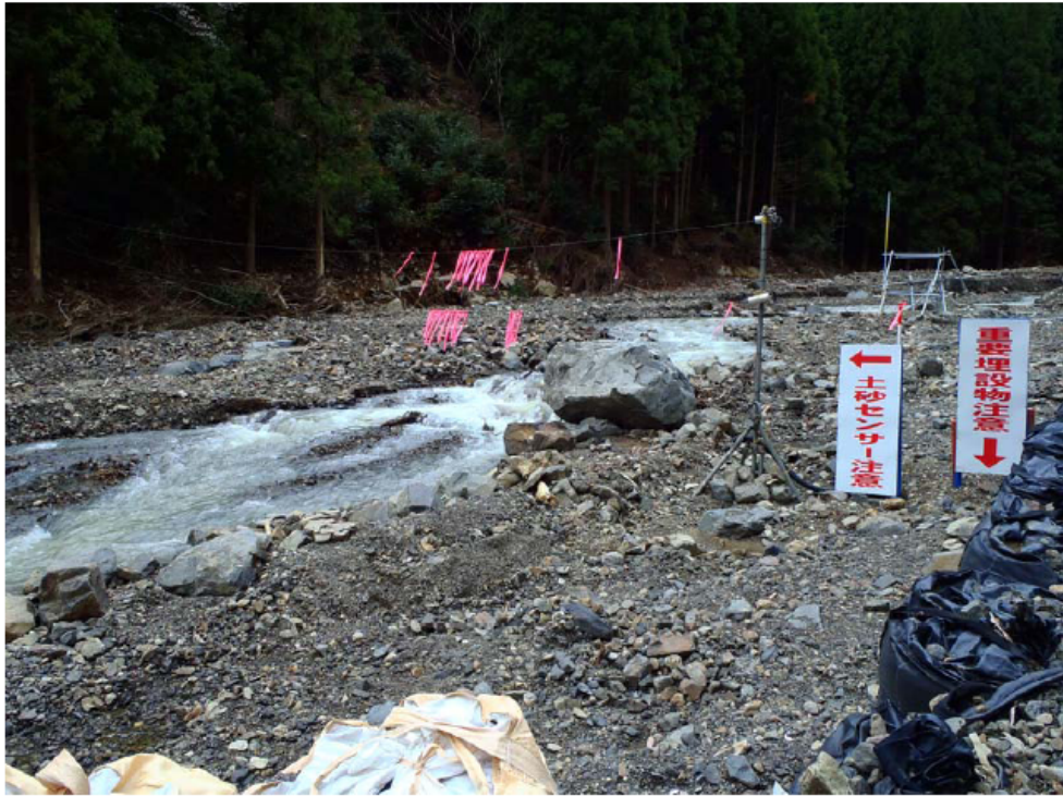
長殿崩壊地の沢の出口には、土石流検知のためのワイヤーセンサーが設置されている。
