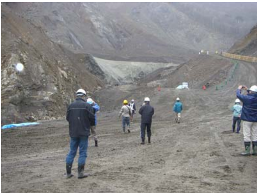
赤谷土砂崩壊現場
