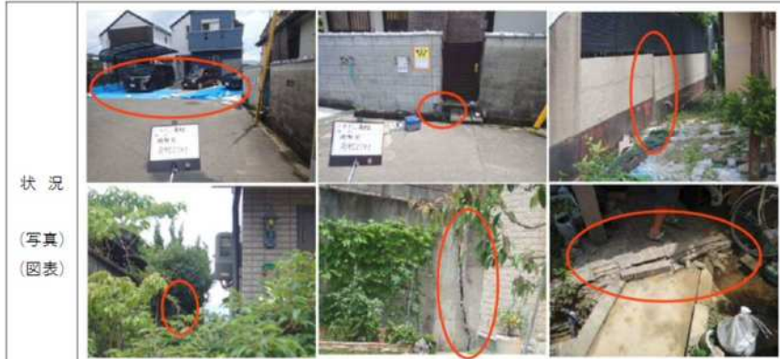
北西から南東方向に向かって地盤のクラック・段差を順番に並べた。切盛り境界付近に連続してクラックが発生している。
