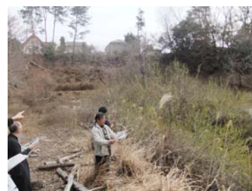
山中比叡平学区自主防災界での調整池上流部法面状況視察
